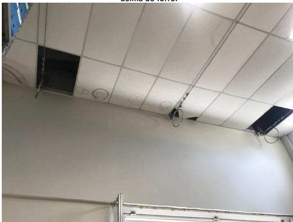
Imagem 10 – Instalação de ancoragens internas com suporte invertido, fixação em viga acima do forro.
