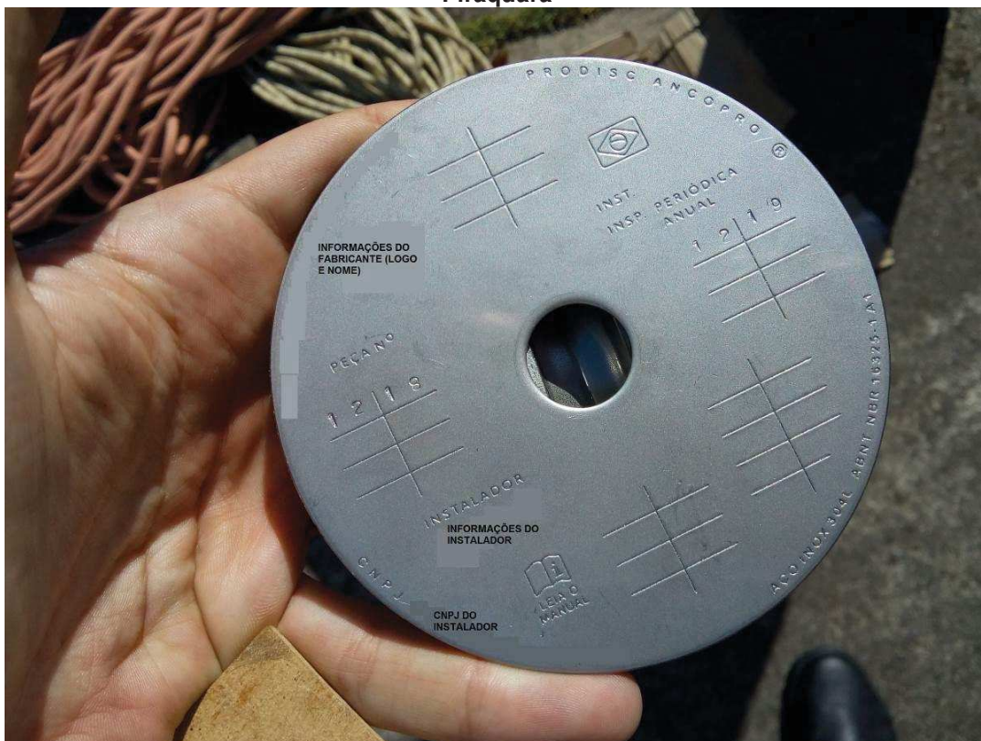
Imagem 2 - Disco de Identificação de Ponto de Ancoragem - Fórum Eleitoral de Piraquara
