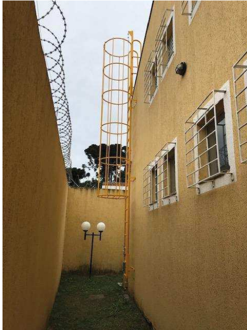
Imagem 17 – Escada Marinheiro Instalada - Fórum Eleitoral de Rio Branco do Sul
