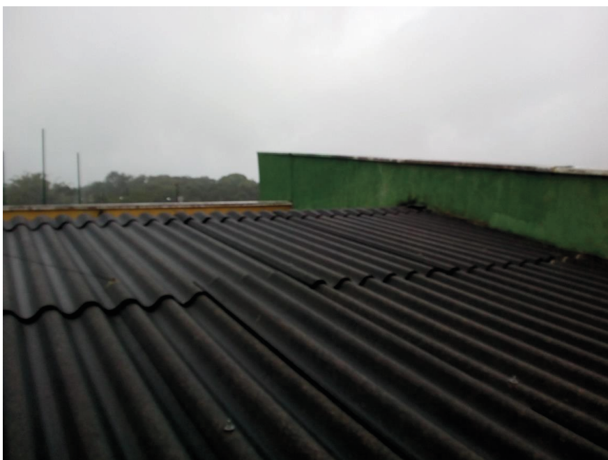
Imagem 5 – Cobertura – Morretes – Situação anterior à execução do sistema de proteção contra quedas.
