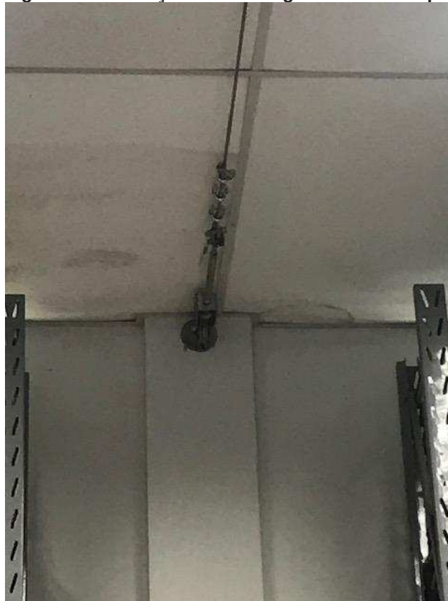
Imagem 9 – Instalação de ancoragem interna em pilar
