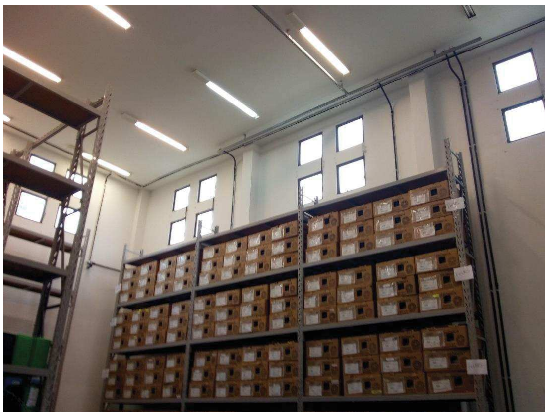
Imagem 12 – Depósito de Urnas – Paranaguá – Situação anterior à execução do sistema de proteção contra quedas.
